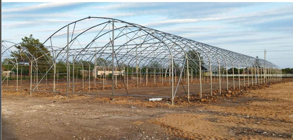
Каркас теплицы изготавливается из ГОСТовского оцинкованного металла. Имеет толщину цинкового покрытия 200 гр. м.кв. Толщина стенок несущих стоек и арок 2 мм. Все крепления хомутовые, что исключает сварочные работы и облегчает процесс монтажа конструкции.
