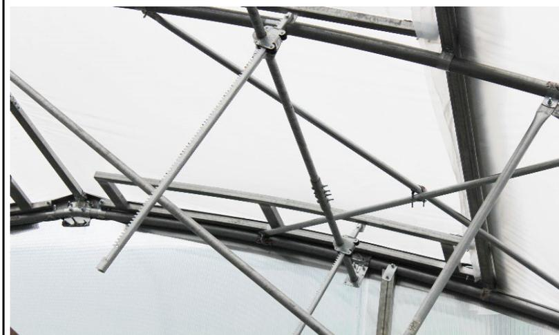
Опора вала имеет крепление под трубу 57 мм. Опора вала монтируется на каждую арку, кроме той, на которой находится мотор-редуктор. В качестве приводного вала используется труба 32x2 мм, которая вставляется в отверстие опоры вала и подшипников зубчатой передачи, проходит вдоль всей теплицы.
