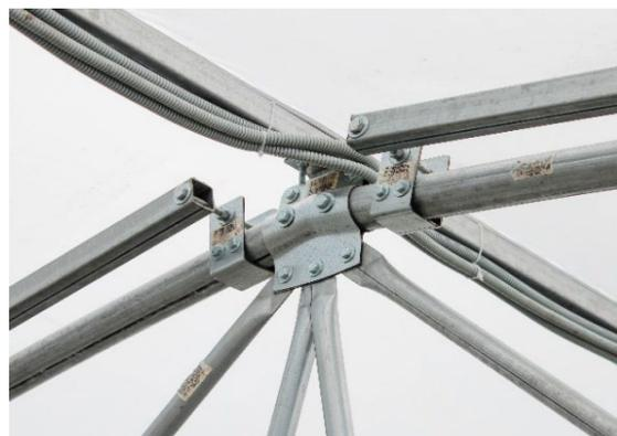
Шпалера горизонтальная изготавливаются из трубы  $\varnothing 32 \times 1,5$  мм. Стяжки арочные вертикальные из трубы  $\varnothing 32 \times 1,5$  мм. При помощи конькового хомута и обжимных хомутов (32 мм и 57 мм), соединяют между собой арку и горизонтальную шпалеру.
