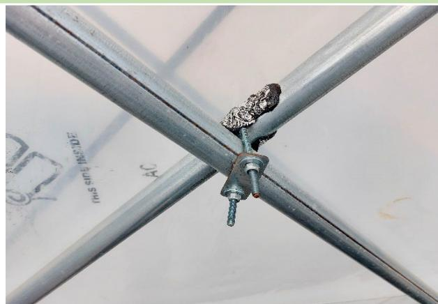
Для получения жёсткости, между фасадом и первой от фасада аркой, с обоих концов теплицы размещаются диагональные раскосы, (крестовые связи) изготовленные из трубы  $\varnothing 32 \times 1,5$  мм. Такие узлы жёсткости размещаются каждые 25 метров. Коньковая перемычка изготовлена из профильной трубы  $40 \times 40 \times 2$  мм. Боковая перемычка изготовлены из профильной трубы  $30 \times 30 \times 2$  мм.
