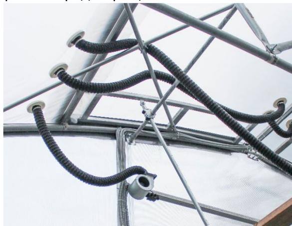
Между слоями пленки при помощи турбины наддува, гофра-шлангов и фланцев врезки, нагнетается воздух, создаётся воздушная подушка толщиной до 20см. Режим подачи воздуха между слоями пленки, контролирует реле времени. Накачиваются все части теплицы включая боковую штору и коньковую форточку.
